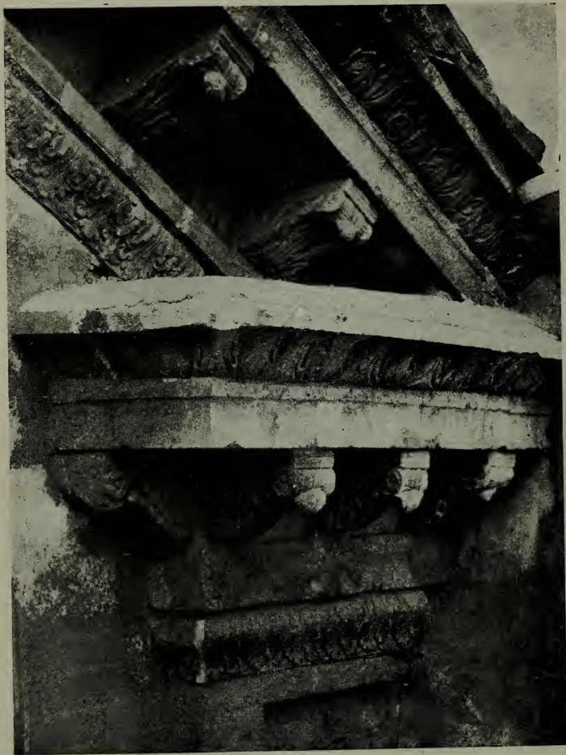
CORNICIONE DEL TETTO DI SANTA MARIA PRESSO SAN SATIRO
